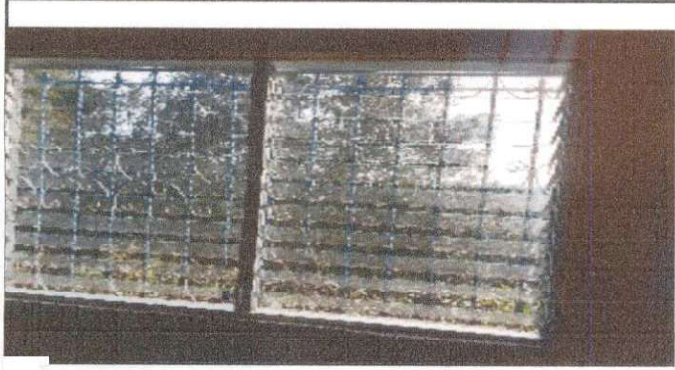
Foto 1: Trabajo remoción de ventanas de aluminio terminado
