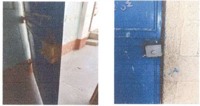
Foto 4: Cambio de chapa en puerta de metal completo
