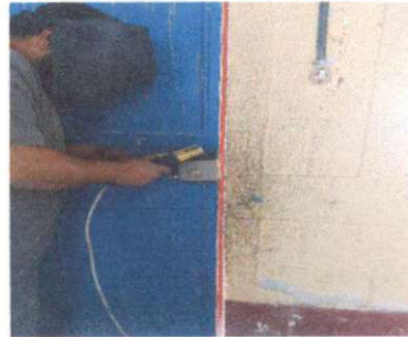
Foto 4: Inicio del Cambio de chapa en puerta de metal
