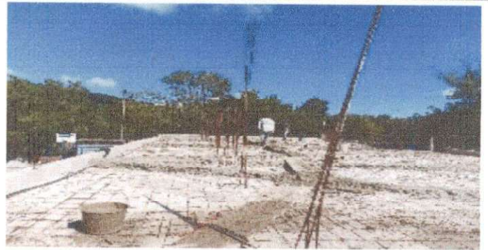
Foto 4: Proceso de resanado e impermeabilización de pañuelos de losa existente
