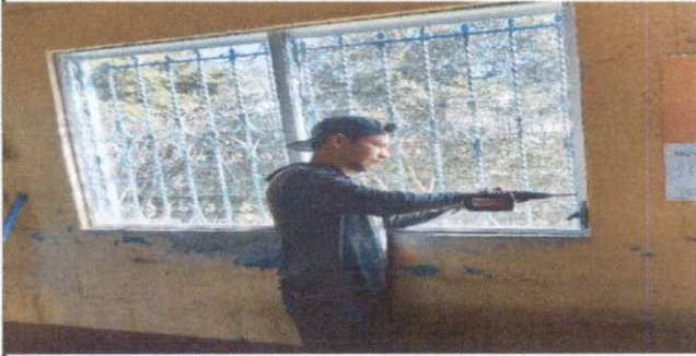
Foto 1: Trabajos en remoción de ventanas de aluminio
