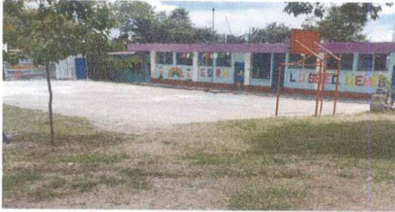
Foto 1: Ingreso a la EODP ANEXA A EORM durante los trabajos
