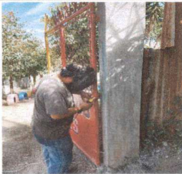
Foto 3: Trabajos de mantenimiento y sustitución de bisagras del Portón
