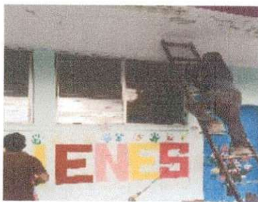
Foto 5: Realización de trabajos en la colocación de balcones de metal, parte de frente
