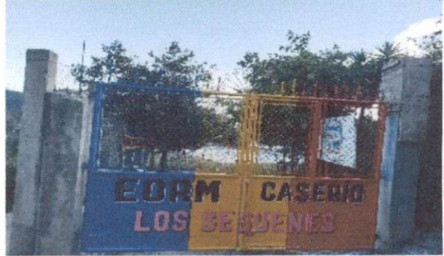
Foto 2: Trabajos en tallado de columnas para colocación de Techo de dos aguas a portón principal
