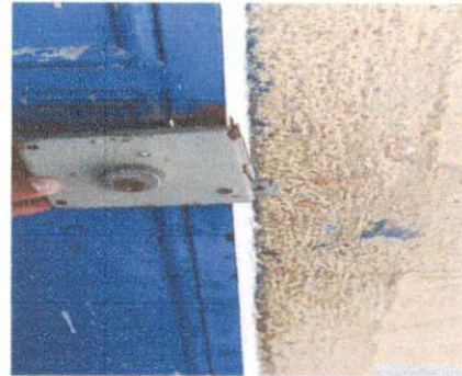
Foto 4: Cambio de chapa en puerta de metal
