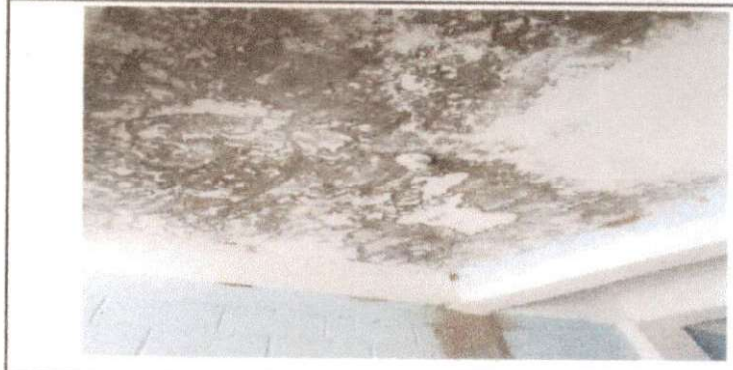
Foto 2: Lado interno dañado salón 1 de losa a remosar
