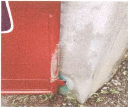
Foto 3: Mantenimiento y sustitución de bisagras del Portón
