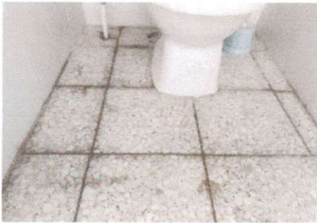
Foto 5: Reparación de tubería de agua potable para sanitario
