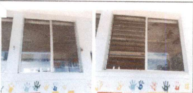
Foto 5: Sustitución de balcones de metal, parte de frente
