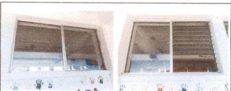
Foto 6: Sustitución de balcones de metal, parte de atrás
