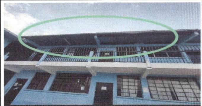
Foto 8: Canal agua pluvial, el cual solo cubre una parte del techo
