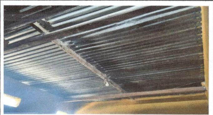
Foto 4: Cambio de costaneras y colocacion de nuevo cableado para electricidad.
