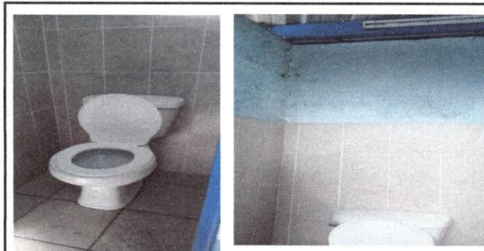
Foto 11: Sustitución accesorios inodoros (contrallave, tubo abasto)
