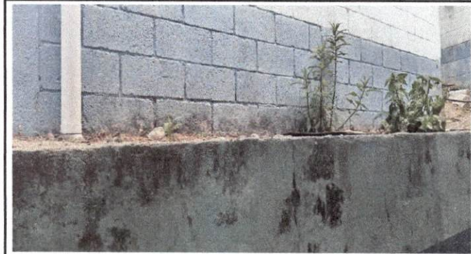
Foto 21: Reparación de muros de contención
