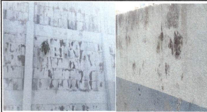
Foto 7: Pintura en muros interiores
