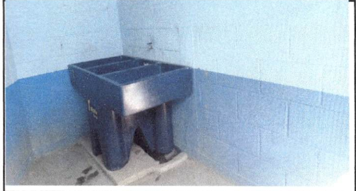
Foto 20: Sustitución de pila por pila de cemento de dos lavaderos
