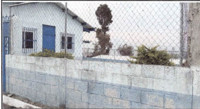
Foto 9 : Pintura en muros exteriores
