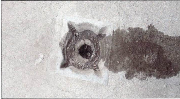
Foto 13: Reparación red de drenaje
