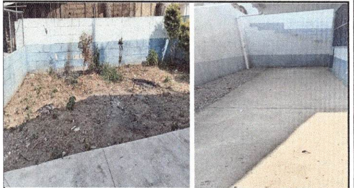
Foto 16: Losa de Patio
