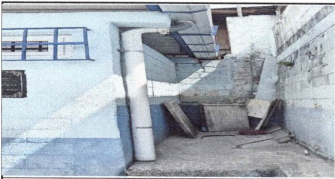
Foto 5: Reparación de canales de agua pluvial
