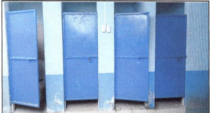
Foto 10 :Sustitución accesorios inodoros (contrallave, tubo abasto)
