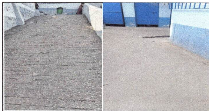
Foto 17: Losa de patio
