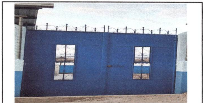
Foto 12: Mantenimiento de portón
