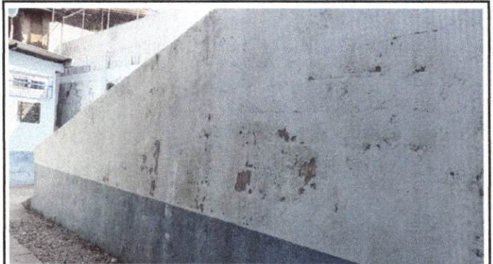
Foto 8: Pintura en muros interiores
