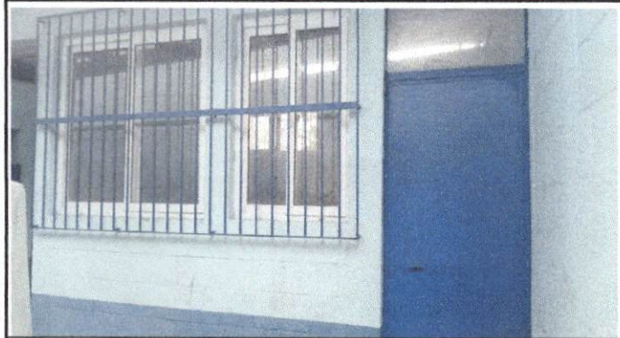
Foto 19: REPARACIÓN DE COCINA
