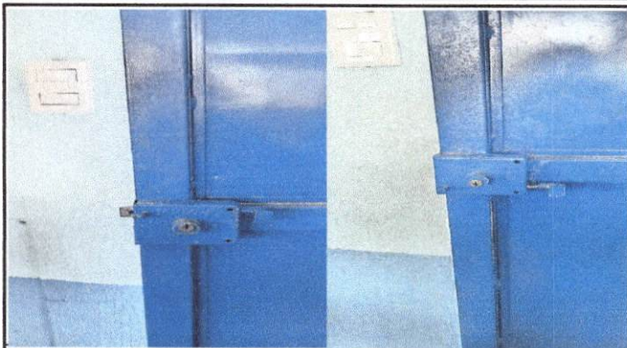
Foto 1: Sustrucción de chapas
