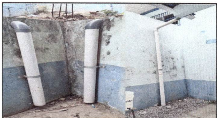
Foto 4: Reparación de canales de agua pluvial
