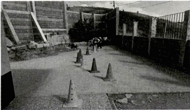
Foto 3: Reparación de loza y patio
