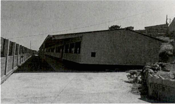
Foto 1: Reparación de corredor y patio
