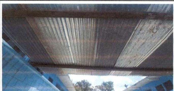
Foto 3: En muchas ocasiones se han tenido que suspender y reducir las actividades debido a las fuertes lluvias y aire ya las costaneras ya están muy deterioradas.
