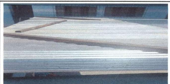
Foto 6: En muchas actividades se ha tenido que buscar soluciones (colocando costaneras adicionales para reforzar el deterioro de las que se encuentran pero deterioradas).
