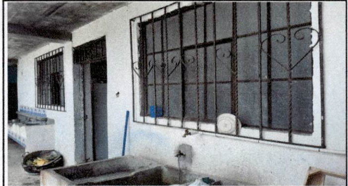
Foto 3: Cambio de ventanas y balcones del área de cocina
