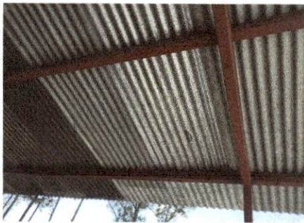
Foto 3: Suministro y mantenimiento de costaneras.
