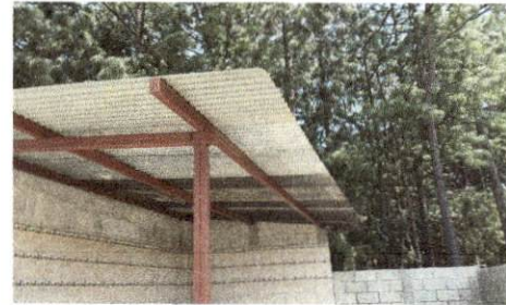
Foto 4: Muro de contención para asegurar la cocina.
