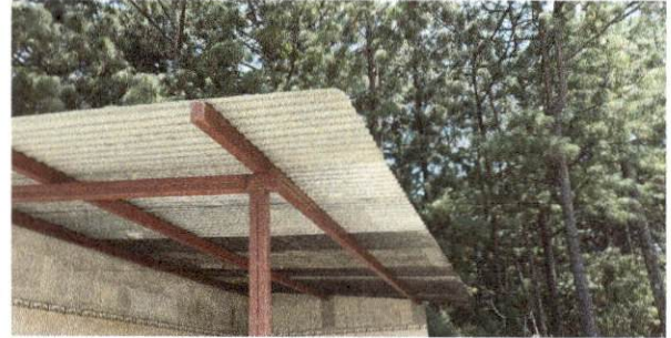
Foto 2: Cambio de estructura de techo y cubierta de lámina
