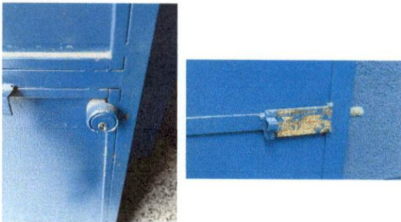
Foto 5: Remozamiento en puertas de metal.
