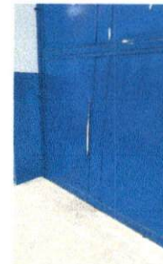
Foto 6: Remozamiento en el portón del establecimiento
