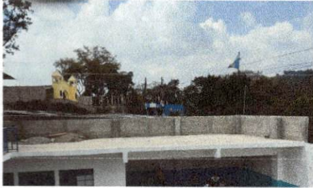
Foto 7: Mantenimiento de baranda, cercana a la cocina
