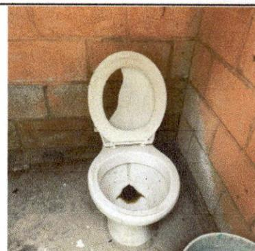
Foto 6: Módulo B, sanitarios en mal estado
