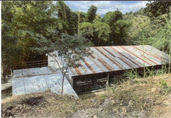
Foto 1: Módulo A, lámina en mal estado
