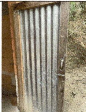
Foto 5: Módulo B, puertas en mal estado
