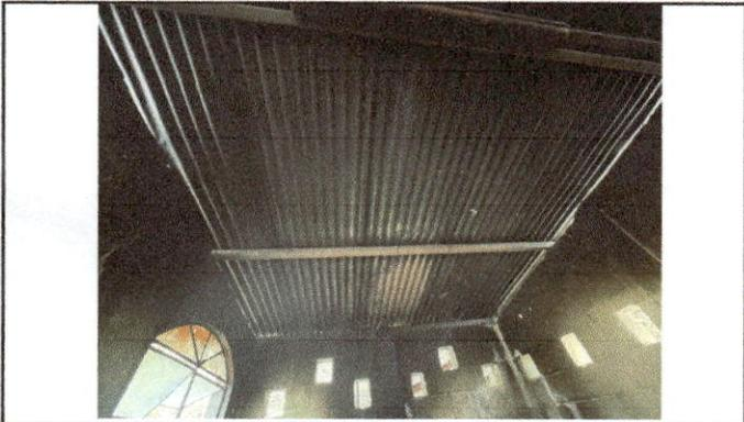
Foto 9: Módulo C, lámina en mal estado
