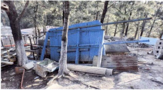
Foto 1: Por la inclemencias del tiempo nuestra bodega que estaba elaborada con lamina y parales de madera colapsó.
