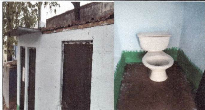
Foto 1 Remozamiento de sanitarios.
