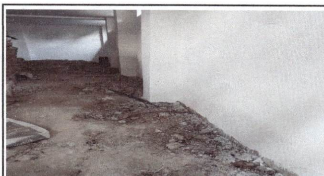
Foto 4. Instalación de piso modulos 1,2,3
