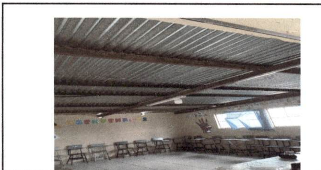
Foto 11: reparacion del sistema electrico en los 10 salones
