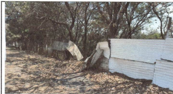
Foto 3: Ampliación de muro perimetral.
