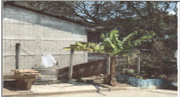
Foto 2: Ampliación de muro perimetral.
