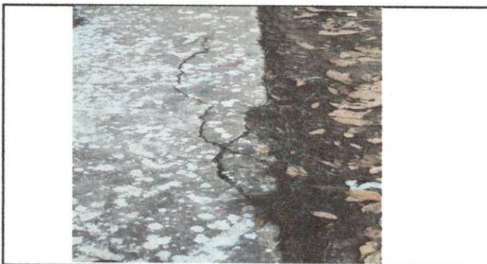
Foto 5: Reparación y ampliación de losa.
