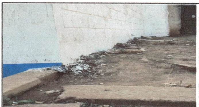
Foto 4: Reparación y ampliación de losa.
