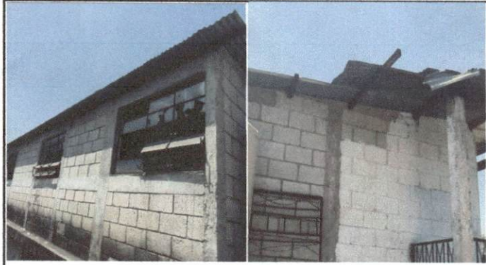
Foto 1: Levantado de techo y mantenimiento.
