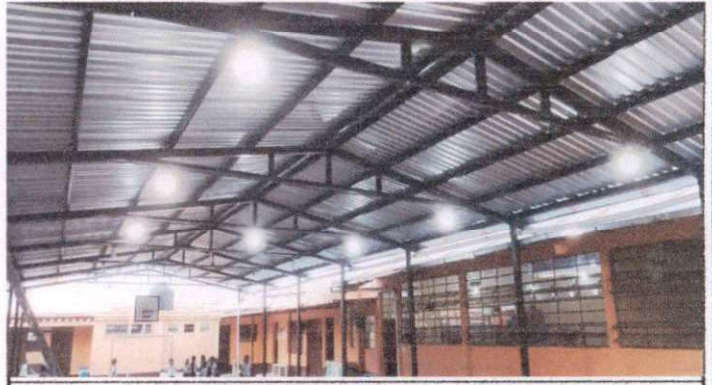
TRABAJO FINALIZADO DE COMETIDA ELECTRICA EN GALERA DEL PATIO.
