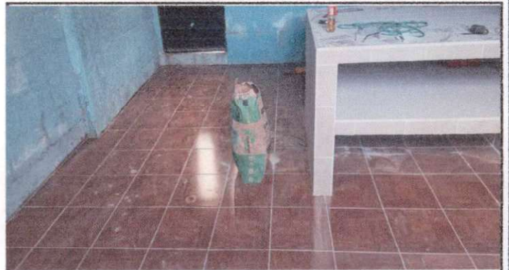
TRABAJO CULMINADO EN COCINA DE PISO CERÁMICO
