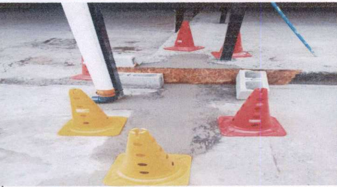
TRABAJO FINALIZADO DE AGUA PLUVIAL.
