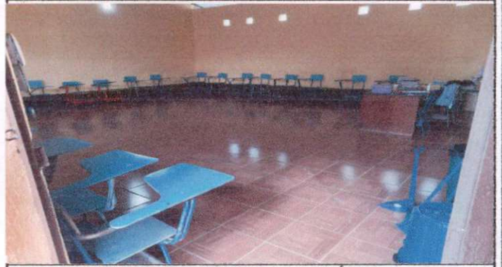
TRABAJO CULMINADO EN SALON 2 DE PISO CERÁMICO
