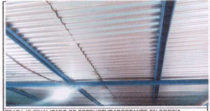
TRABAJO FINALIZADO DE ESTRUCTURAPORTANTE EN COCINA.
