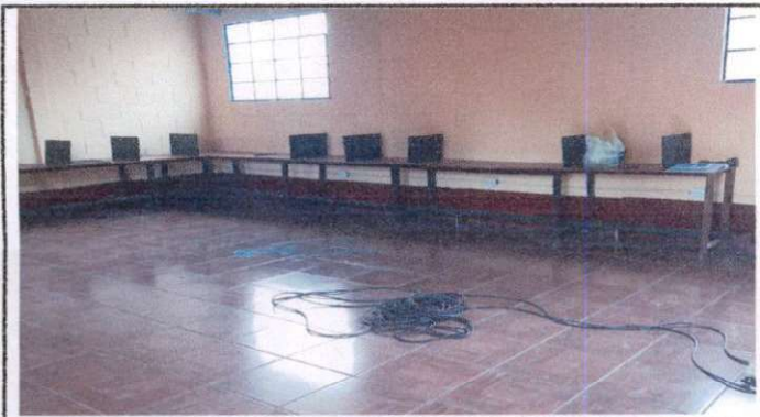
TRABAJO CULMINADO EN EL SALON 3 DE COMPUTACIÓN PISO CERÁMICO
