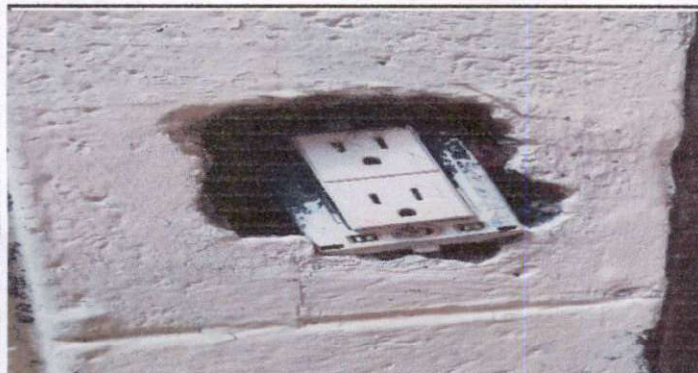
SUSTITUCIÓN DE TOMACORRIENTES EN SALÓN DE COMPUTACIÓN
