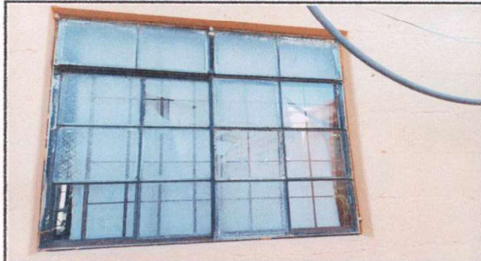
CAMBIO DE VENTANA DE VIDRIO POR METAL
