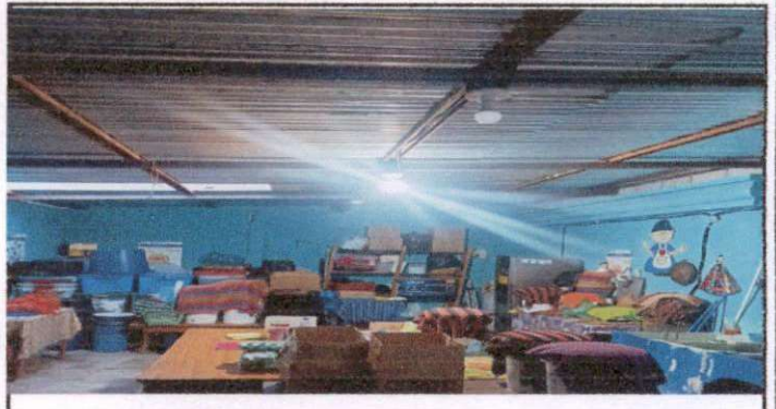
SUSTITUCIÓN DE UNA LÁMINA EN COCINA.
