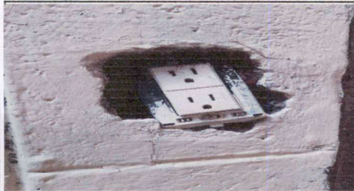
SUSTITUCIÓN DE TOMACORRIENTES EN SALÓN DE COMPUTACIÓN
