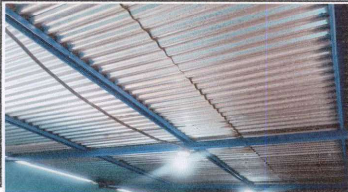
MANTENIMIENTO A ESTRUCTURA PORTANTE DE LA COCINA
