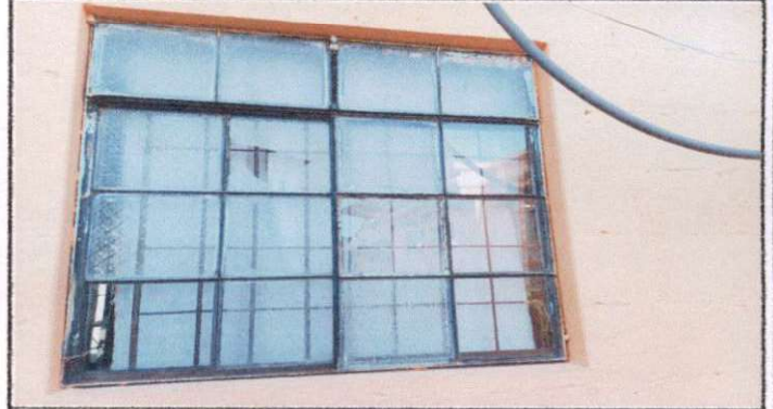
CAMBIO DE VENTANA DE VIDRIO POR METAL
