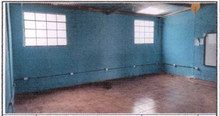
REPARACIÓN DE TOMACORRIENTES EN EL SALÓN DE COMPUTACIÓN.
