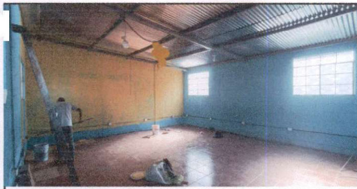
PINTURA INTERIOR SALÓN DE COMPUTACÓN.
