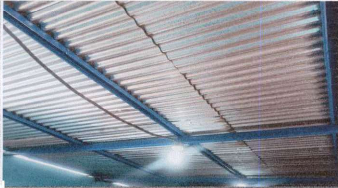
MANTENIMIENTO A ESTRUCTURA PORTANTE DE LA COCINA
