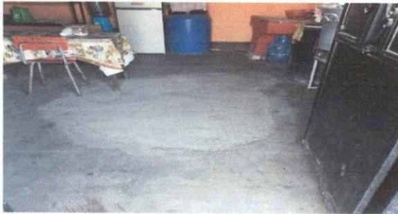
Foto 3: Colocar piso antideslizante en área de cocina, la torta anterior se empezó a undir por filtración de agua de tuberías principales, se visualiza un parche cementado del reparo.
