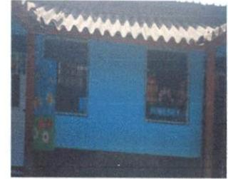
Foto 2: Area de patio que necesita cambio de tejas y costaneras en techo por lamina troquelada las cuales estan quebradas y en epoca de lluvia se filtra el agua.
