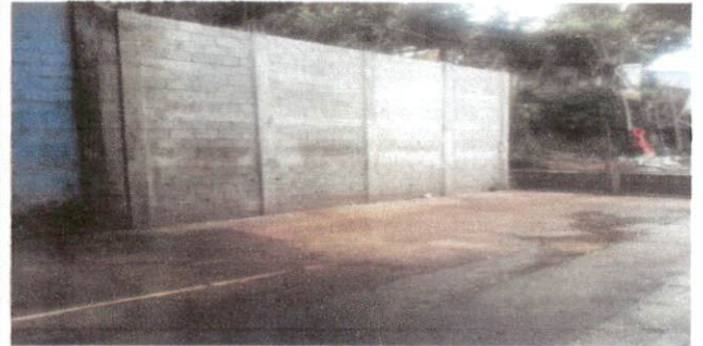
Foto 6: Terminado del muro de contención con las especificaciones indicados del proyecto.
