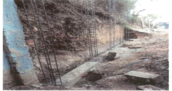
Foto 2: Fundición de columna y cimiento corrido para la colocación de block.
