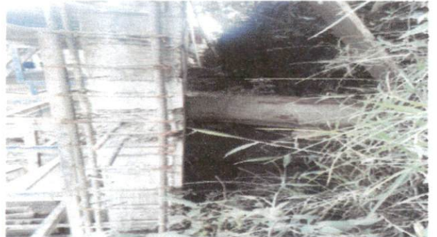
Foto 4: Colocación de 3 anclajes en forma de ele al inicio, intermedio y final de la pared para mayor seguridad.
