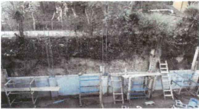
Foto 3: Construcción de la mitad del muro de contención.
