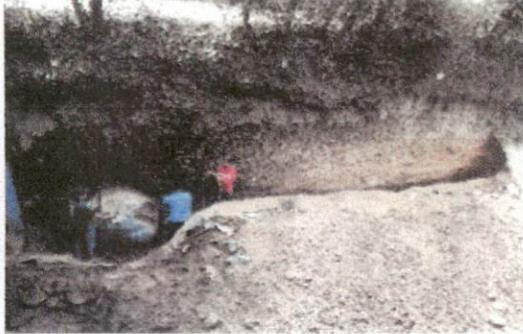
Foto 1: Los señores albañiles realizan la excavación de zanja y demolición de roca.
