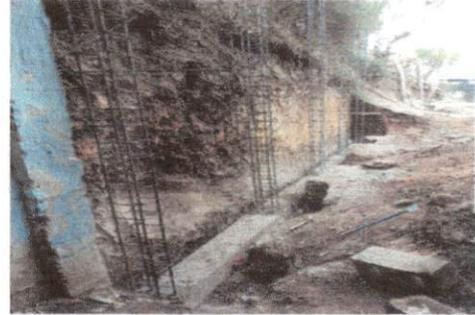
Foto 2: Realización de colocación, parado y fundición de columna así mismo fundición de cemento corrido.
