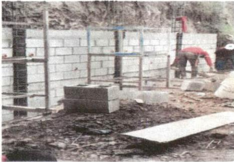
Foto 3: Levantado del muro de contención de los primeros dos metros de altura por 10 metros de largo.
