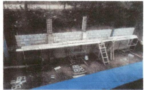
Foto 4: Hechura de armazón de cajón de madera para la fundición de las columnas.
