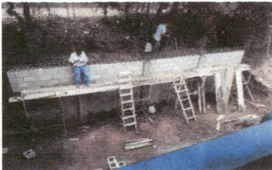
Foto 5: Colocación de andamio para facilitar el levantado y colocación de solera y armazón para la siguiente fundición.
