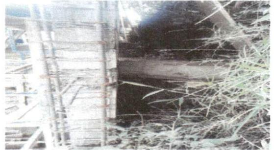
Foto 6: Colocación de anclajes detrás de muro de contención.
