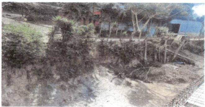
Foto 5: La pendiente forma parte de una vía de acceso en el que transitan vehículos livianos y pesados el cual podría colapsar por el peso.
