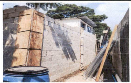
Foto 2: Sustitución de techo de cocina escolar de la Escuela Oficial de Parvulos Anexa a EORM JM
