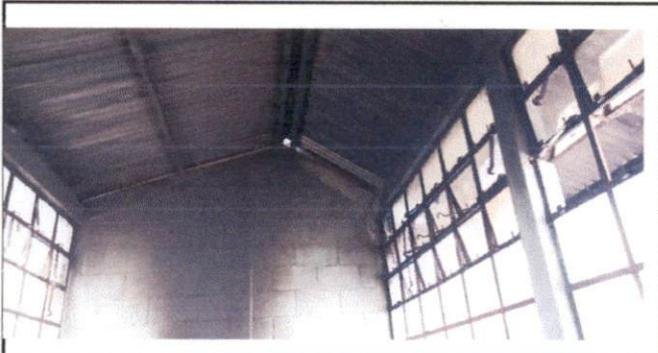
Foto 3: El techado de la cocina es de lámina en mal estado no es el adecuado, uno de los factores que se evidencia es el espacio cerrado, es el único espacio disponible para la preparación de los alimentos.
