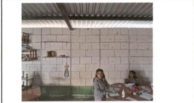
Foto 3: la imagen muestra que las aulas no poseen ventilacion cruzada y en los tiempos de verano es mucho el calor. Por eso es un gran necesidad poder tener ventanas en las aulas.
