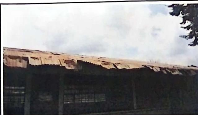
Foto 5: Laminas galvanizadas que se sustituiran por laminas troqueladas zinc calibre 26 .
