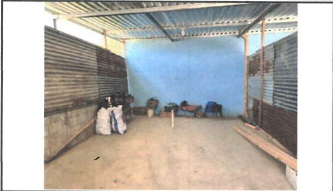
Foto 1: Salón de clases con muros provisionales de lámina.
