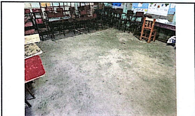
Foto 4: Se cuenta únicamente con piso de torta de cemento, por lo que se propone colocar piso de granito.
