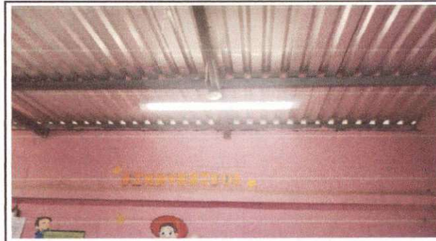
Foto 4: Cambio de lámina acanalada por lámina troquelada alucin calibre 26, visto de la parte interior..
