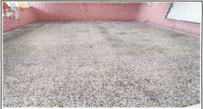
Foto 2: Terminado de colocacion y cizado de piso aula 1
