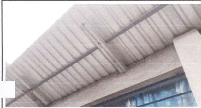
Foto1: Finalizado cambio de lámina acanalada por lámina troquelada alucin calibre 26.
