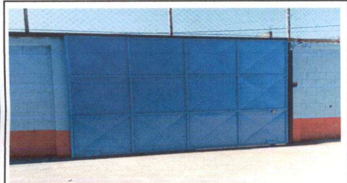
Foto 3: Finalización de mantenimiento de portón, parte de adentro.
