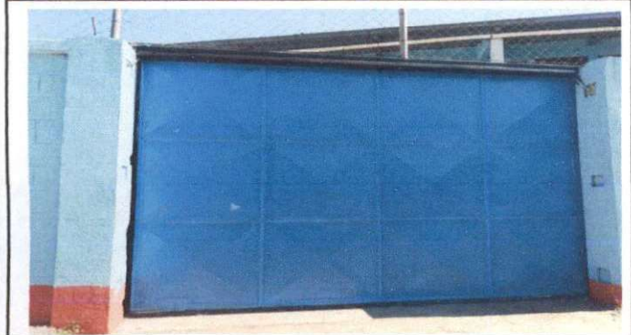
Foto1: Finalización de mantenimiento de portón visto de la parte de afuera.
