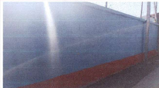
Foto 2: Terminado de pintura patio principal.
