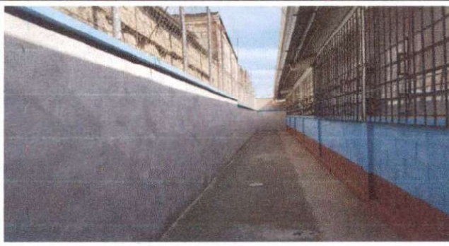
Foto 4: Finalización de fundición de banqueta.
