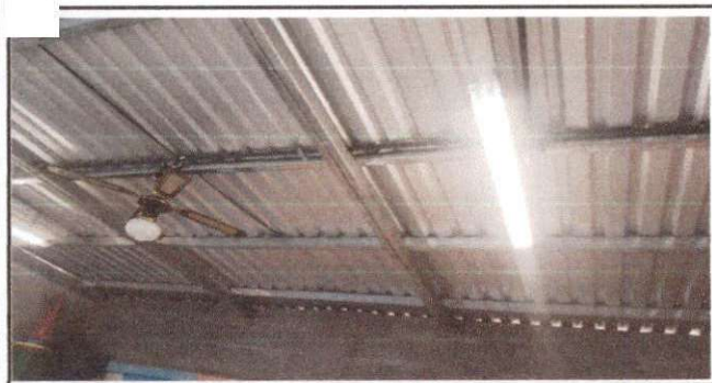
Foto 5: Cambio de lámina acanalada por lámina troquelada alucin calibre 26, visto de la parte interior..
