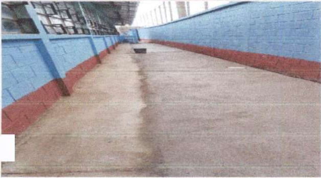
Foto 1: Terminado de pintura en callejón.
