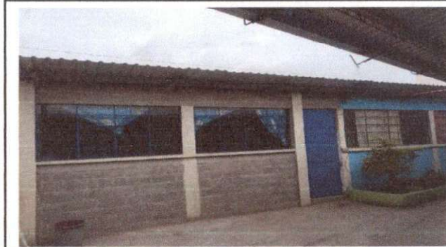
Foto 2: Finalización del proyecto cambio de lámina acanalada por lámina troquelada alucin calibre 26.
