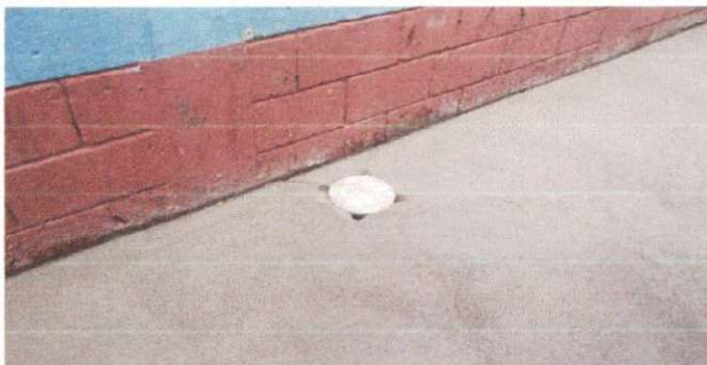
Foto 6: Reposadera, fundición de banqueta.
