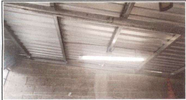
Foto 3: Cambio de lámina acanalada por lámina troquelada alucin calibre 26, visto de la parte interior.
