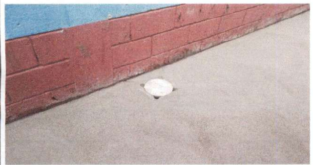
Foto 3: Colocación de tapadera para reposadera.
