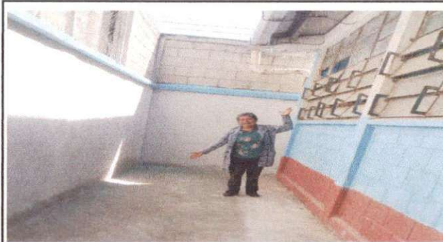
Foto 4: Proyecto finalizado de repello de pared.
