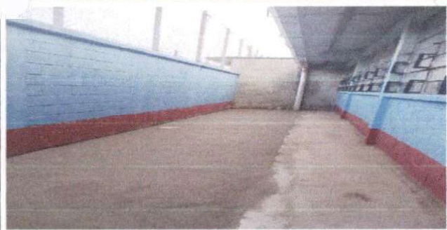
Foto 5: Fundición de banqueta.
