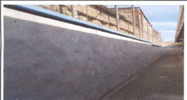
Foto 3: Repello de pared terminado.
