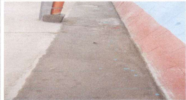
Foto 2: Finalización de zanja para calda de aguas fluviales.
