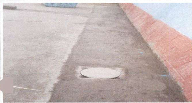
Foto 1: Finalización reposadera para aguas fluviales.
