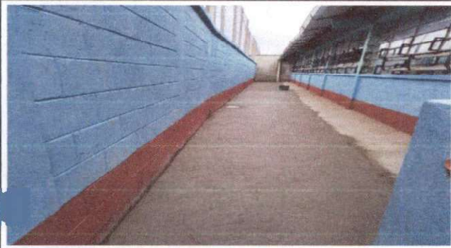
Foto1: Fundición de banqueta finalizado.
