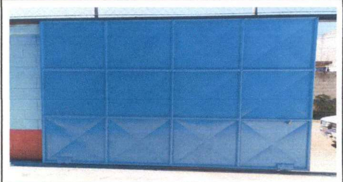
Foto 2: Finalización de mantenimiento de portón, parte de adentro.
