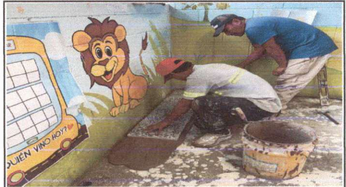
Foto 4: .Ejecución de colocación de piso
