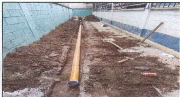
Foto 3: Colocación de tubo pvc para aguas fluviales para fundición de banqueta.
