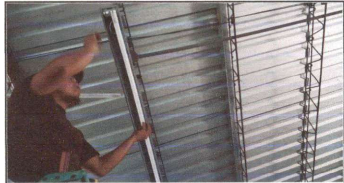
Foto 4: INSTALACION DE LAMPARAS LED
