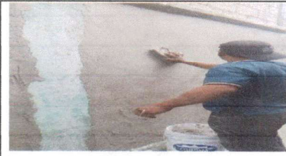
Foto 4: Aplicación de repello.
