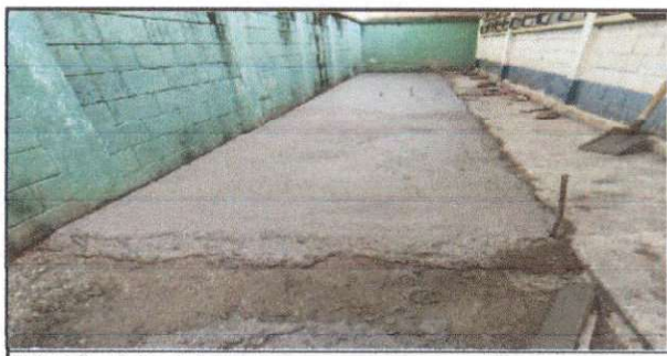
Foto 6: Fundición de banqueta.
