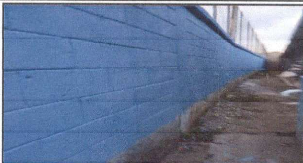
Foto 2: Aplicación de pintura, parte superior de la pared.
