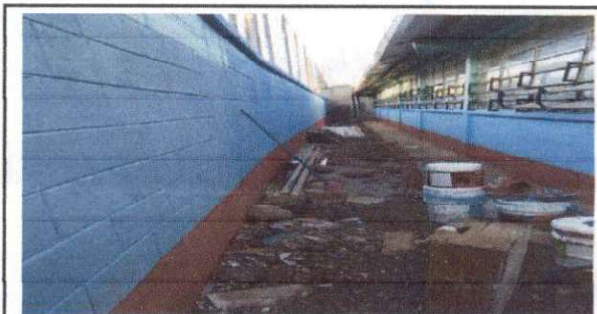
Foto 4: Aplicación de pintura en los callejones.
