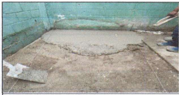
Foto 5: Inicio de fundición de banqueta.
