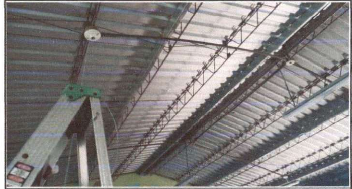
Foto 2: MEJORAMIENTO DE ILUMINACION EN SALONES SEGUNDO NIVEL.
