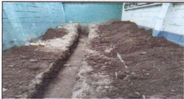
Foto 2: Elaboración de zanja para tubería de drenaje.
