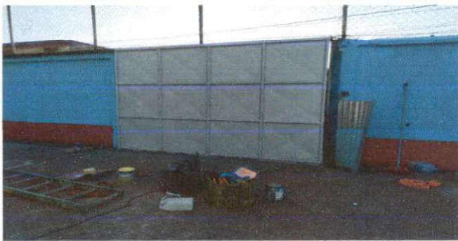
Foto 5: Aplicación de pintura para capa protectora.
