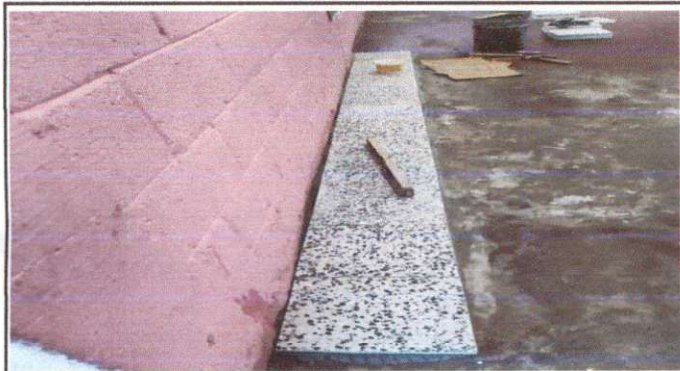
Foto 3: Iniciando a colocar piso en AULA 1
