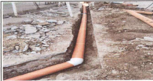
Foto 6: Ensamblado de tubo pvc.
