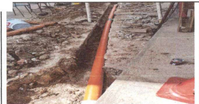
Foto 5: Colocación de tubo Pvc para aguas fluviales.
