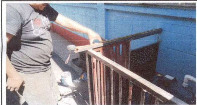
Foto 3: .Medición de estructura de cubierta para bomba de agua.
