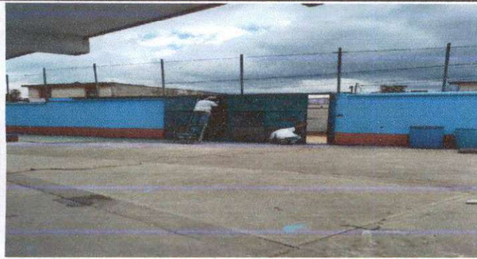
Foto 1: Lijado de portón para mantenimiento.
