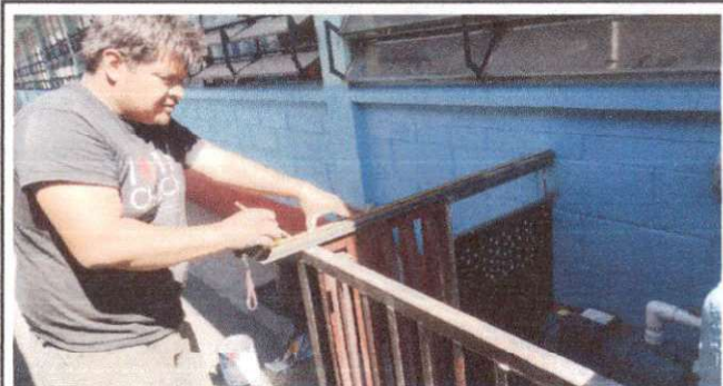
Foto 2: Medición de estructura de cubierta para bomba de agua.
