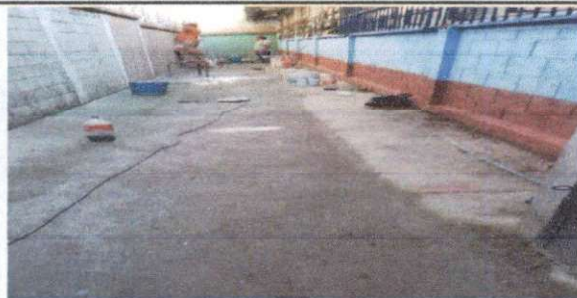
Foto 5: Aplicación de repello.
