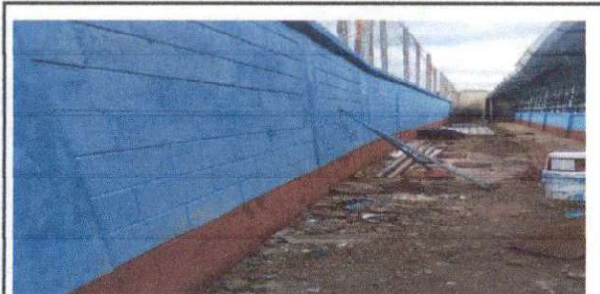
Foto 5: Aplicación de pintura parte superior y socalo.
