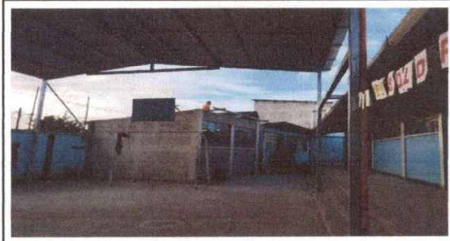
Foto 4: Avance de retiro de lámina acanalada.
