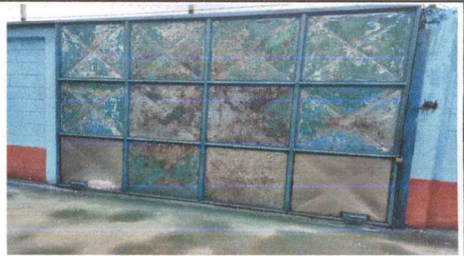
Foto 2: Cambio de lámina en dos secciones del portón.
