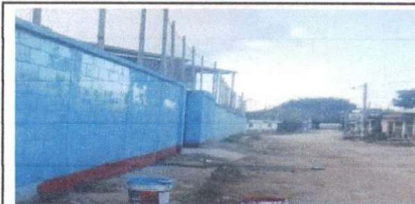
Foto 6: Aplicación de pintura parte exterior del establecimiento.
