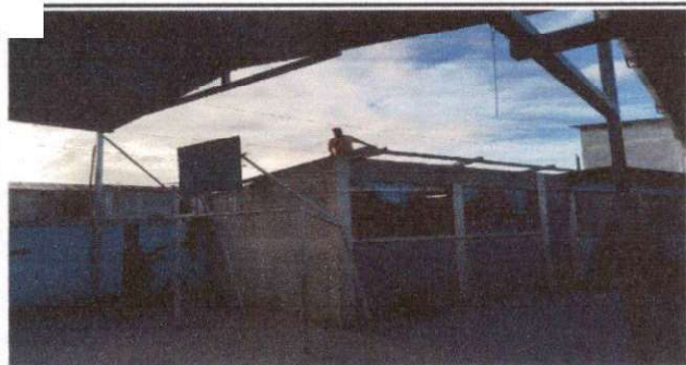
Foto 5: Proceso de retiro de lámina acanalada.
