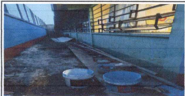
Foto 3: Aplicación de pintura de socalo.
