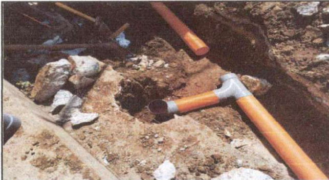
Foto 4: Unión de tubos pvc para aguas fluviales.
