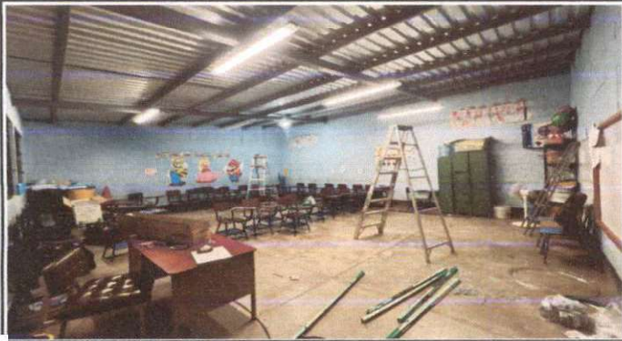
Foto1: AULA 3RO. SEC. A SEGUNDO NIVEL.
