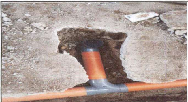
Foto 3: Colocación de tubo pvc para reposadera.
