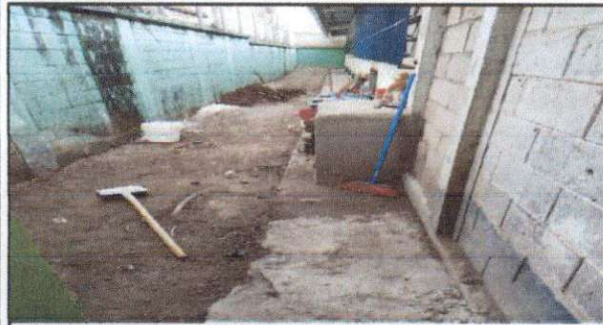
Foto 1: Inicio de trabajo de drenaje y fundición de banqueta.
