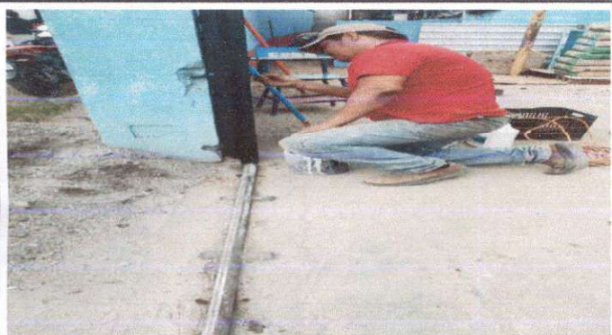
Foto 3: Aplicación de pintura del marco de portón número 1.
