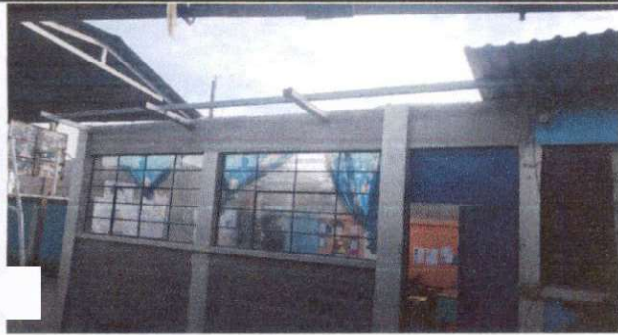
Foto 1: Início de cambio de lámina acanalada por lámina troquelada alucin calibre 26.
