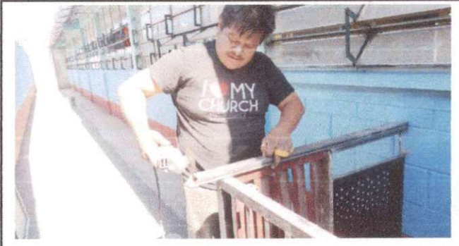
Foto 4: Preparación de corte de estructura de metal para protección de bomba de agua.
