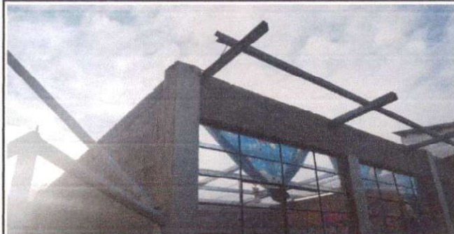
Foto 2: Retiro de lámina acanalada por lámina troquelada alucin calibre 26.
