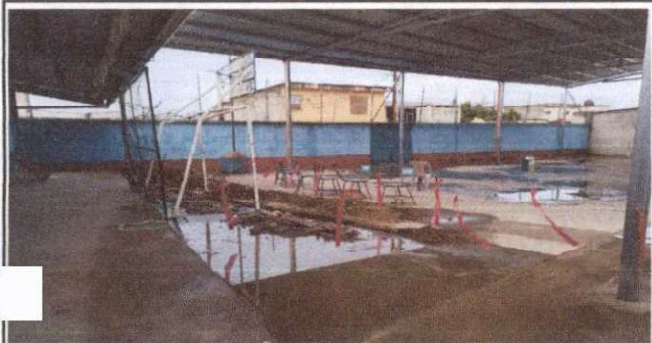
Foto1: Elaboración de zanja para aguas fluviales.
