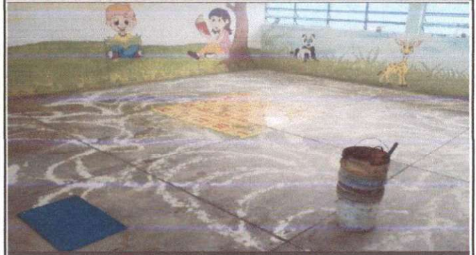
Foto2: Proceso de aplicación de ácido muriático para lavado de superficie.
