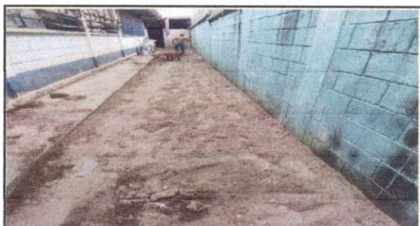
Foto 4: Relleno de zanja y nivelación de terreno.
