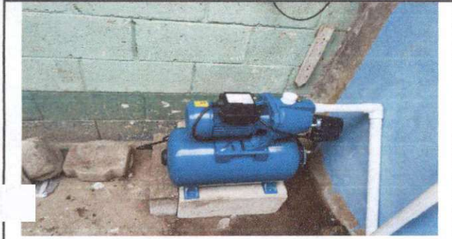
Foto1: Colocación de nueva bomba de agua.
