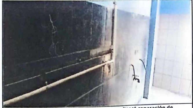
Foto 2: Imagen que muestra la parte que se realizará reparación de tuberías de drenajes, agua potable para inodoros, lavamanos y mingitorios.
