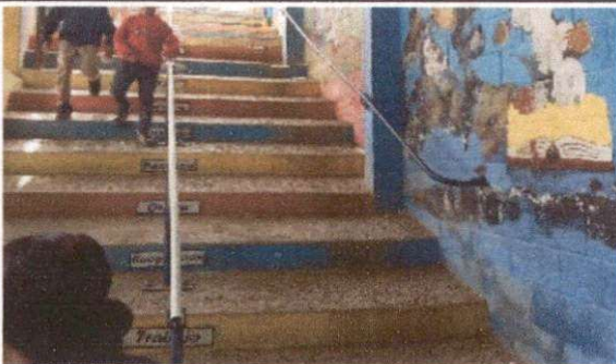
Foto 5: Los pasamanos de la entrada junto a las barrandas presentan oxidación constante debido al material del cual están hechos, por lo que precisan cambio a material inoxidable.
