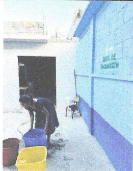
Foto 5: Se necesita un módulo de gradas para habilitar una bodega en la parte superior de la cocina.
