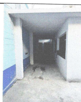
Foto 4: También se colocará piso en el área de pasillo que colinda con la cocina.
