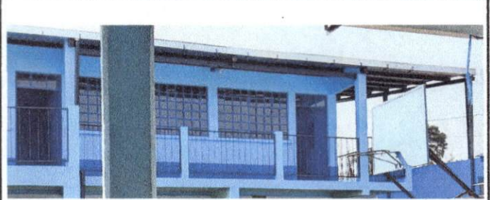
Foto 2: Colocación de vidrios faltantes.
