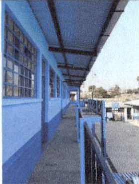
Foto 1: Cambio de estructura metálica.
