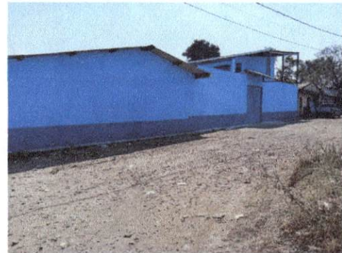
Foto 4: Pintura en muro exterior.
