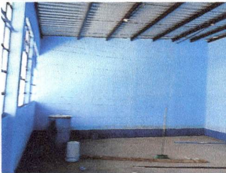
Foto 3: Cambio de lámina y pintura en estructura metálica.
