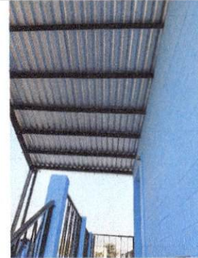
Foto 2: Cambio de lámina y pintura en estructura metálica.
