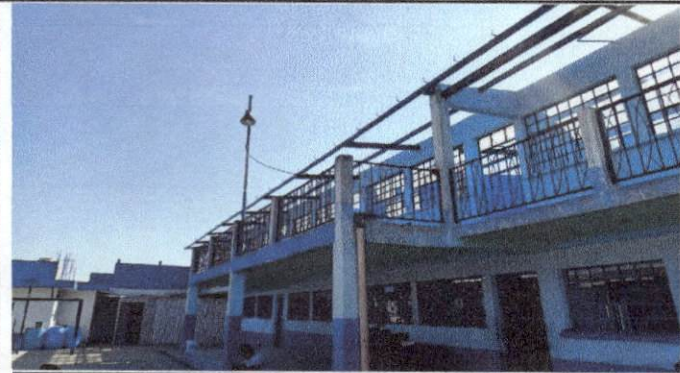
FOTO 1: EN ESTA FOTO ESTAN DANDO MANTENIMIENTO A STRUCTURA METALICA DEL TECHO DE 5 CINCON AULAS EN SEGUNDO NIVEL
