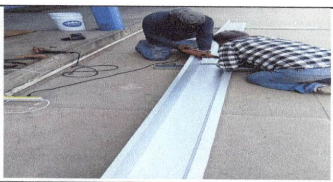
FOTO 5: PREPARANDO EL CANAL PARA COLOCARLO
