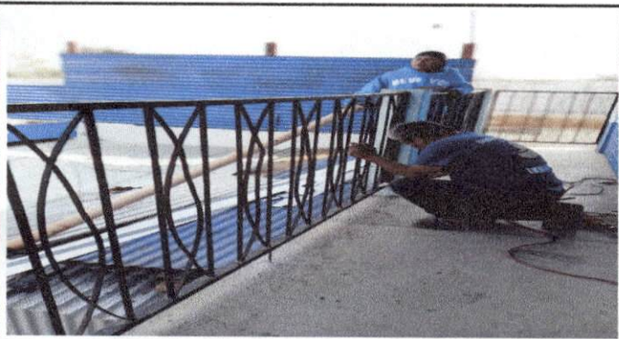
FOTO 3 ESTAN DESMONTANDO LA BARANDA PARA HACERLE EL MANTENIMIENTO
