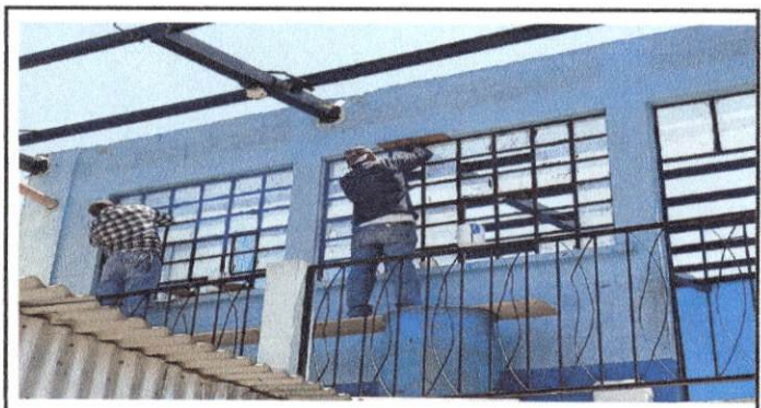
FOTO 4: DANDOLE MANTENIMIENTO A LA ESTRUCTURA METALICA DE LAS VENTANAS EN SEGUNDO NIVEL EN AULAS
