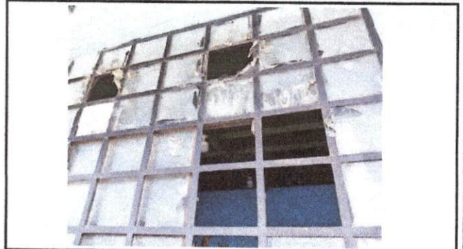
Foto 2: Situación de ventanas.
