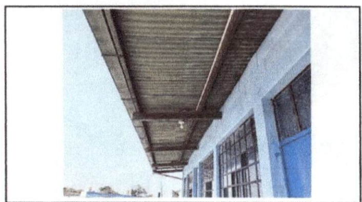
Foto 4: Situación actual de estructura metálica.
