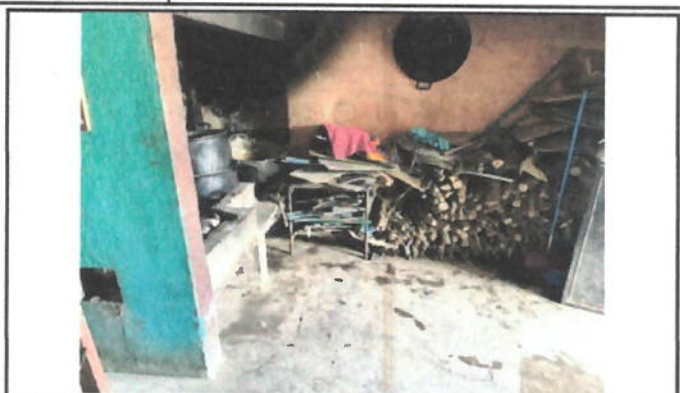
Foto 8: Se colocará piso en el área de cocina.
