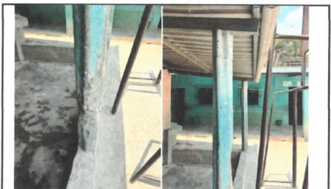
Foto 10: Sustitución de 3 columnas de concreto, por columnas Metálicas de 4x4"
