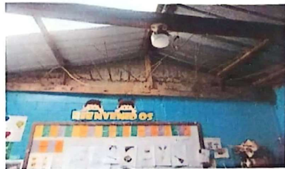
Foto 6: Por las malas condiciones del cableado, se sustituye por el cambio total del sistema eléctrico (C toma corriente, bombillas, cables y plafoneras)
