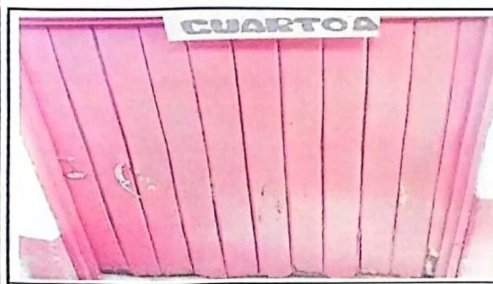
Foto 5: sustitucion de cuatro puertas en dos aulas
