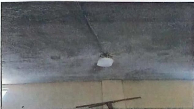
Foto 5: la imagen muestra el repello en mal estado de la loza el cual será sustituido por un repello nuevo.
