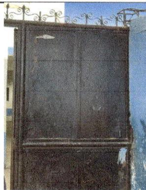
Foto 10: Módulo C, portón deteriorado con corrosión
