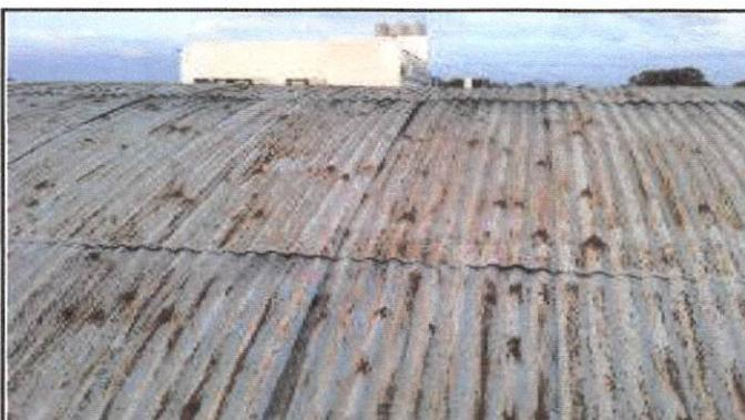
Foto 4: Lamina que se necesita cambiar
