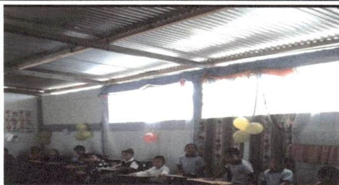
Foto 2: Lamina en mal estado de salón de usos múltiples
