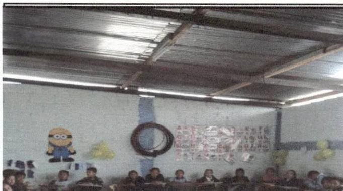
Foto 3: La mala condición de la lamina permite la entrada de agua en el invierno
