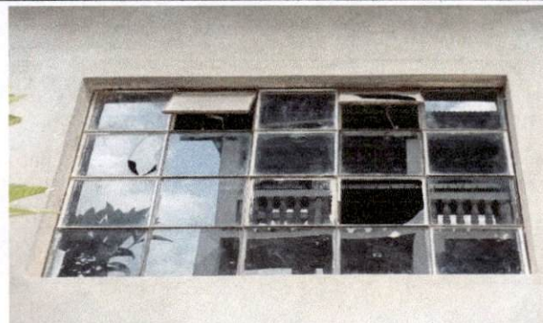
Foto 8: Sustitución de ventanas
