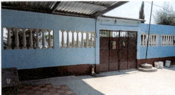
Foto 1: área de reparación de muro y eliminación de botellas
