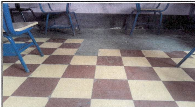
Foto 10: Colocación de piso cerámico en 2 aulas
