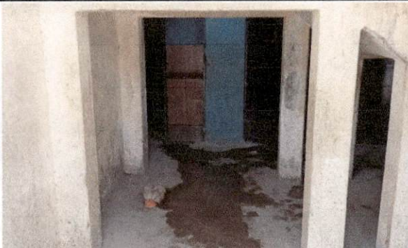
Foto 5: Levantado de pared e instalación de sanitario infantil
