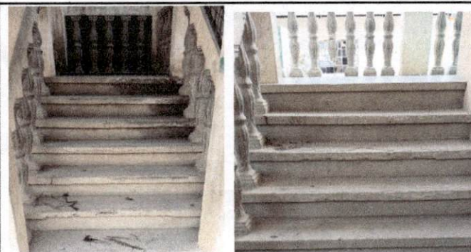
Foto 6: área instalación de piso antideslizante de gradas
