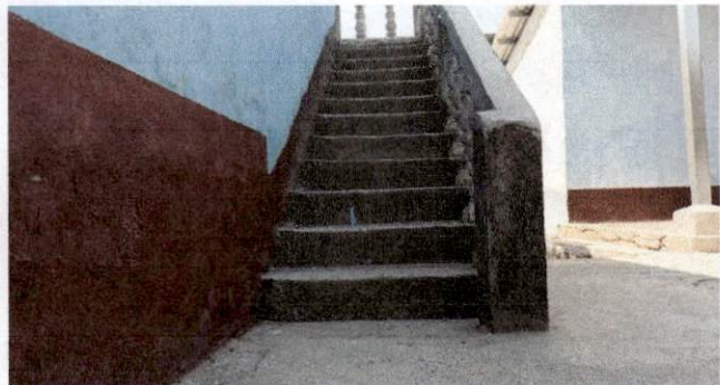
Foto 7: área de instalación de piso antideslizante de gradas
