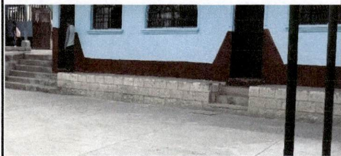
Foto 11: área de colocación de piso antideslizante en corredor
