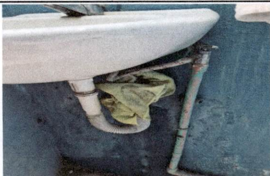
Foto 3: Sustrucción de lavamanos
