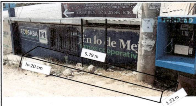
FOTO 2: área de reparación de banqueta
