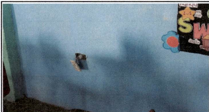
Foto 9: Cambio de repello por humedad
