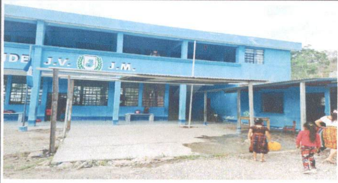
Foto 1. Modulo 1 Sustitución de Techo de Corredor.
