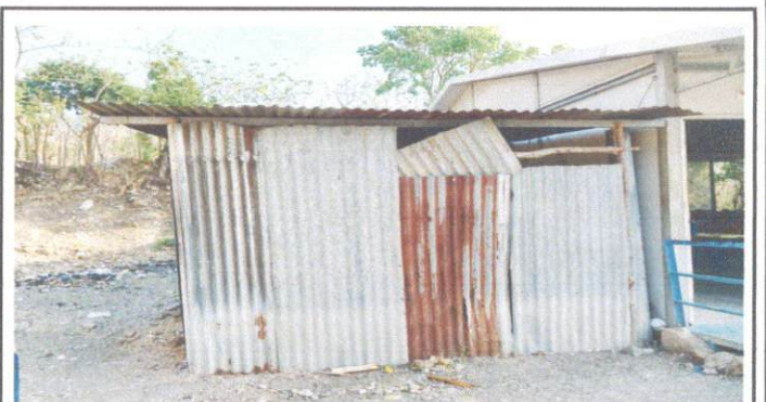
Foto 4. Sustitución de Techo de Bodega
