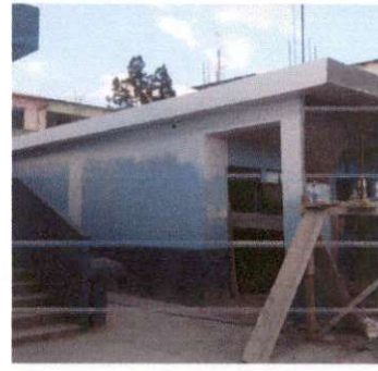
Foto 4: tallada de losa y columnas
