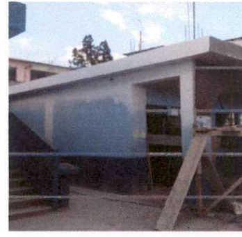
Foto 4: tallada de loza y columnas
