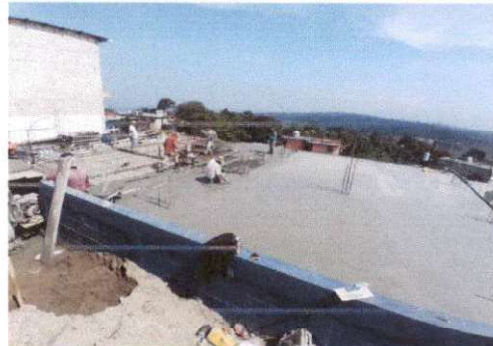
Foto 2: todos trabajando con el concreto y fundición
