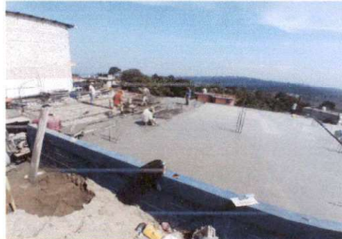
Foto 2: todos trabajando con el concreto y fundición
