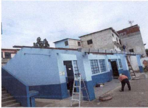
Foto 1: Se empezó a desmontar todo el techo
