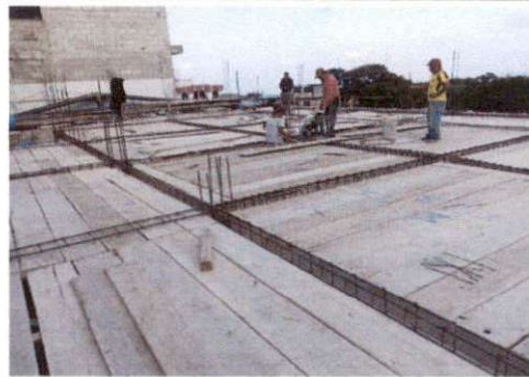
Foto 4: Después de entarimar se procedió a realizar las columnas
