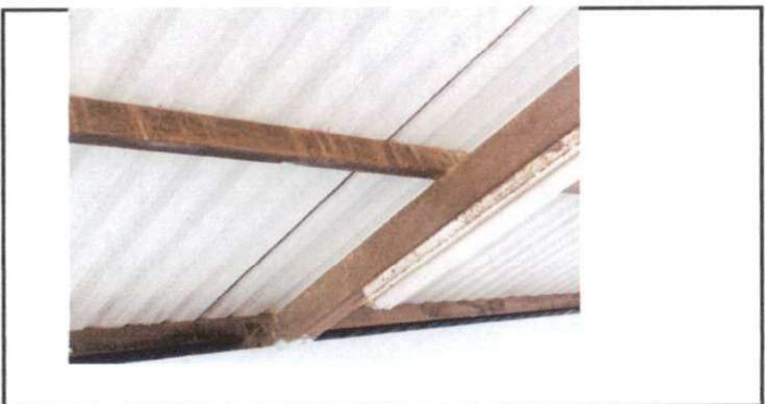
Foto 6: Las bigas se encuentran en mal estado.
