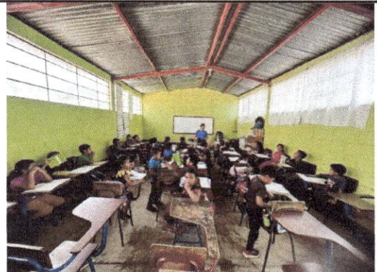
Foto 8: Salón en el cuál se realizará la colocación de piso cerámico.
