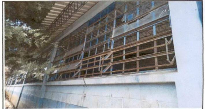
Foto 4: Mantenimiento de ventanería pintura, y vidrios .
