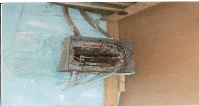
Foto 5: Cambio del tablero de circuitos por antigüedad y mal estado
