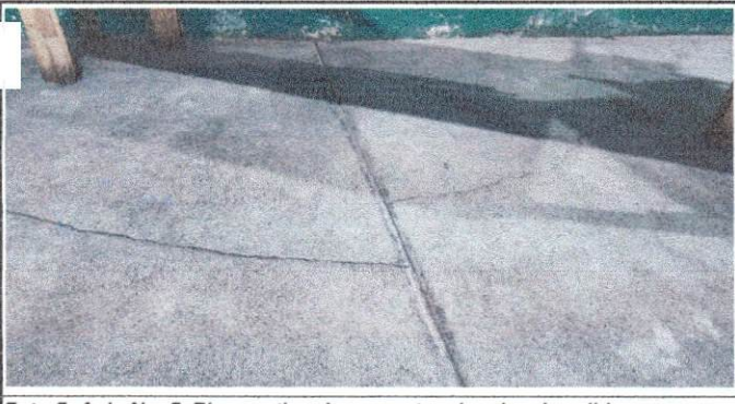
Foto 5: Aula No. 5 Piso rustico de cemento, planchas hundidas y desniveladas.
