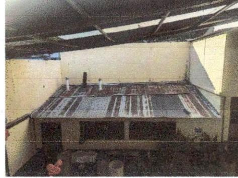
Foto 2: TECHO DE LA COCINA DÓNDE SE VA SUSTITUIR POR LOSA
